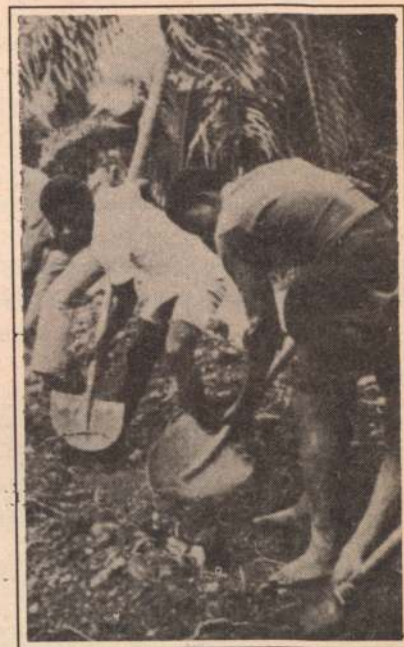
Es trabajando que se aprende a trabajar
